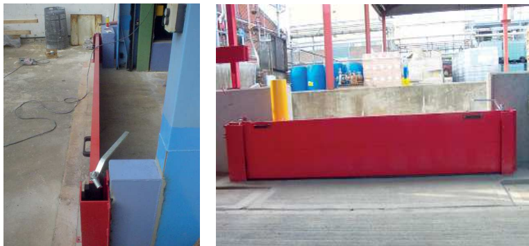
Mise en place d'une barrière de rétention manuelle en une portée.
